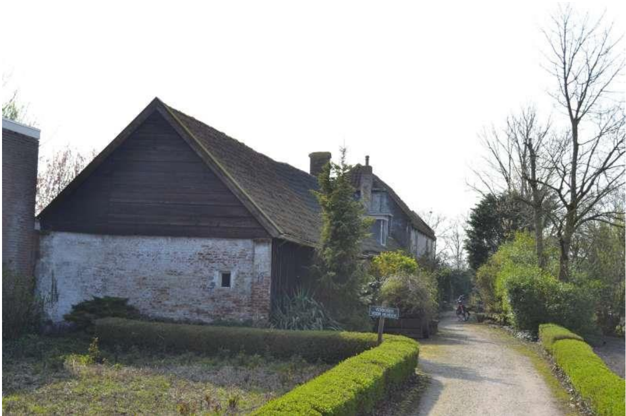
Schuur en woonhuis op het terrein Blauwpoort.
